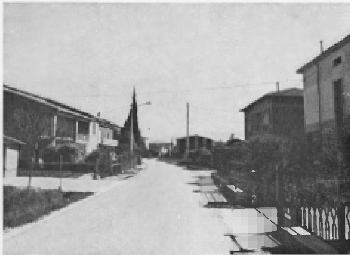
Tordandrea. Bitumatura della strada comunale.
