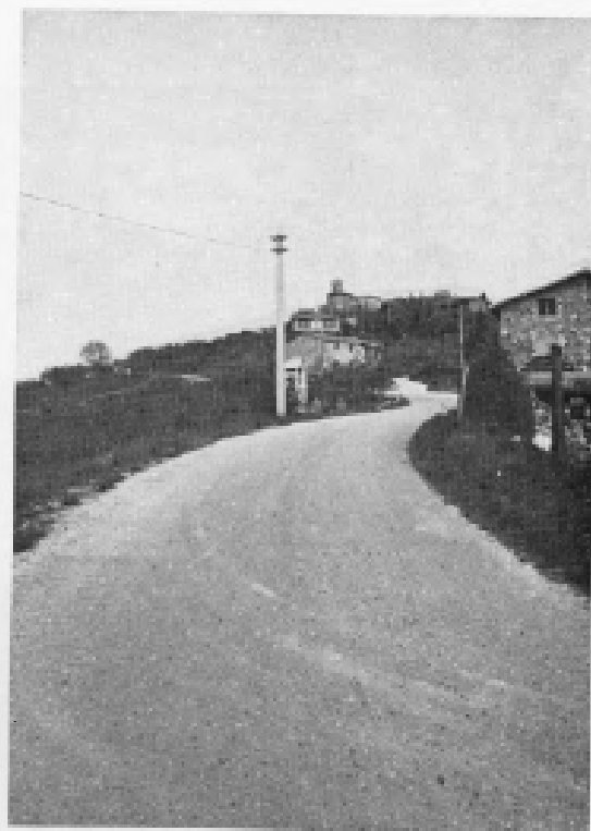
Starnepeto. Bitumatura della strada comunale.
