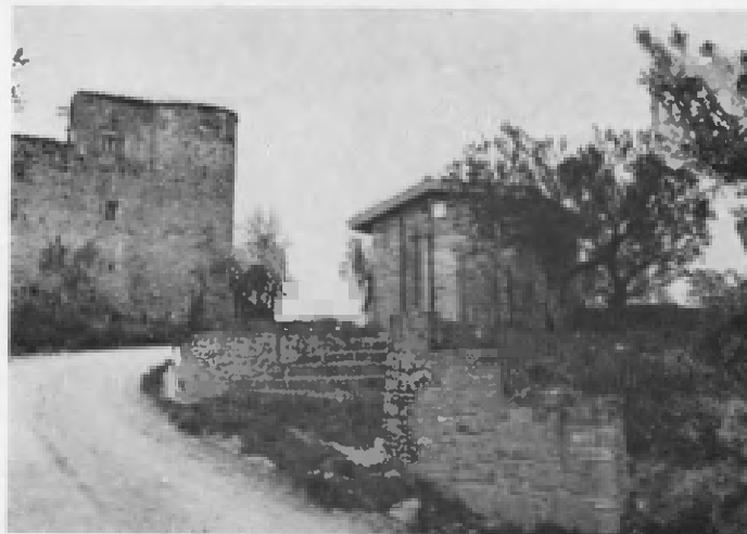
Acquedotto di Stor- peto. Cabina di al- laccio in località Be- viglie.
