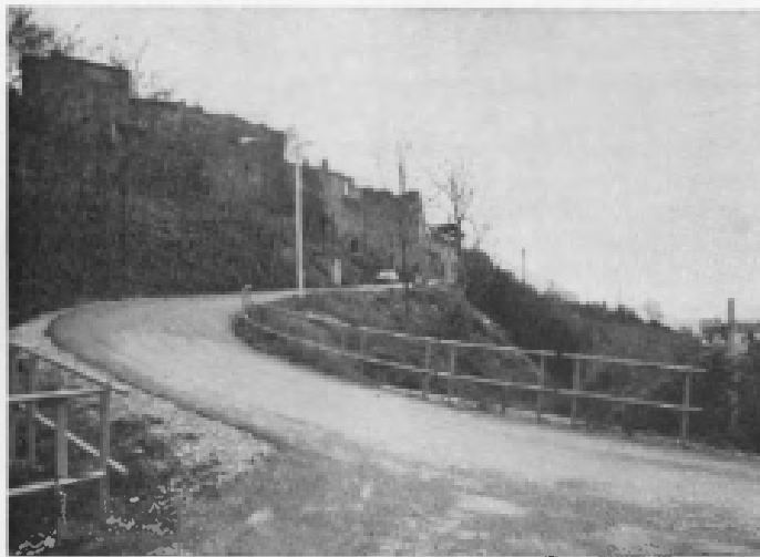
Rocca S. Angelo. Bitumatura della strada comunale.
