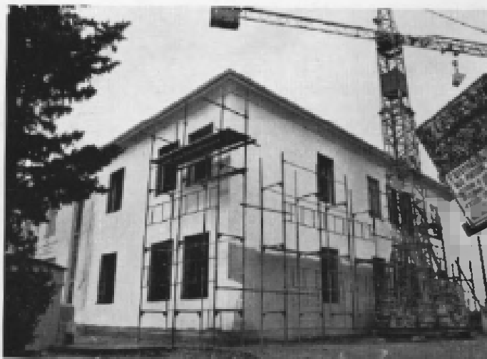
Petignano. Ampliamento edificio Scuole Elementari.
