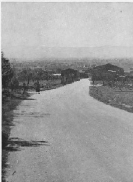
Rivotorto. Bitumatura della strada comunale « La Renniola ».
