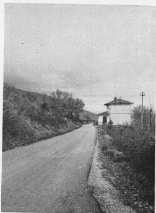
Capodacqua. Bitumatura della strada comunale.
