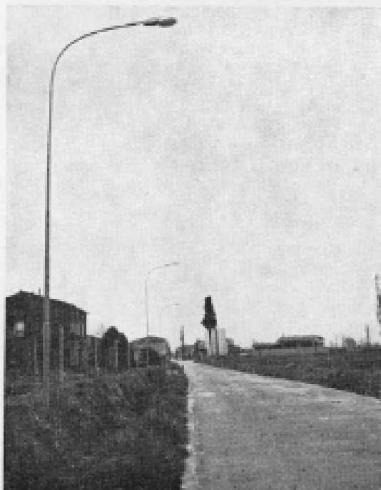
Castelnovo. Potenziamento impianti pubblica illuminazione.
