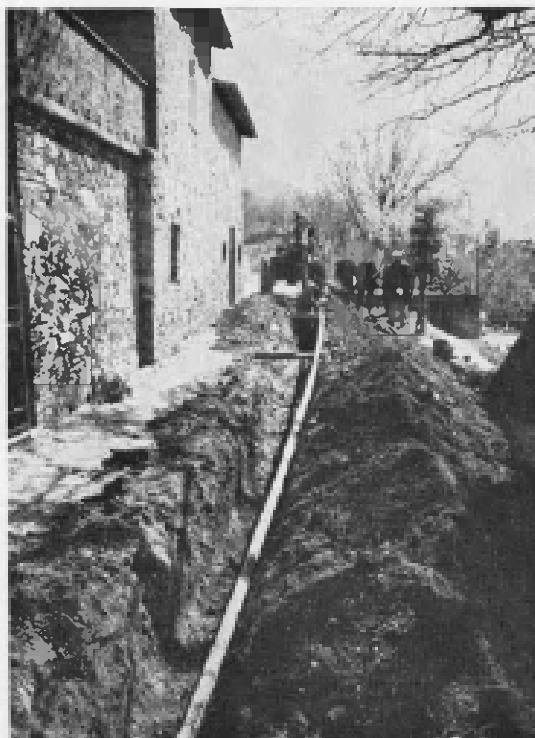
Lavori di miglioramento acquedotto Viola - S. Vitale - Rivatorta. Condotta di adduzione acquedotto S. Vitale.
